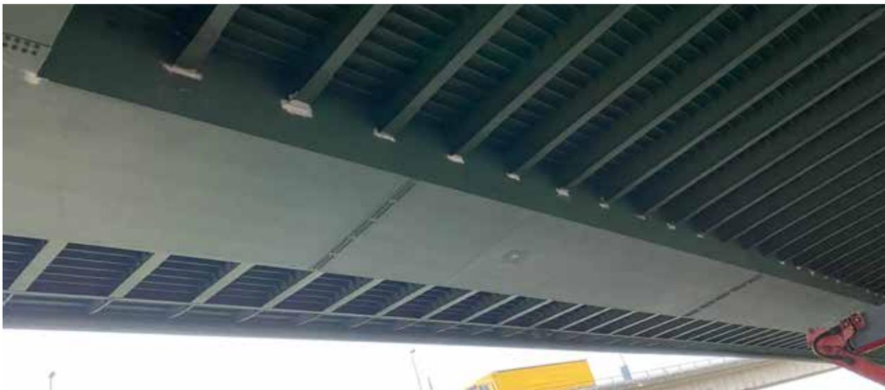
Eine Brückenkonstruktion besteht überwiegend aus Kehlnähten mit T-Stößen. Allfällige Risse an T-Stößen mit Kehlnahtverschweißungen wurden bisher im Rahmen der wiederkehrenden Prüfung visuell oder mit Hilfe des Magnetspulverprüfverfahrens detektiert. Das Reparaturverfahren sah vor, dass diese Risse so lange ausgeschleift und nachgeprüft werden, bis keine Anzeige mehr festzustellen ist.
