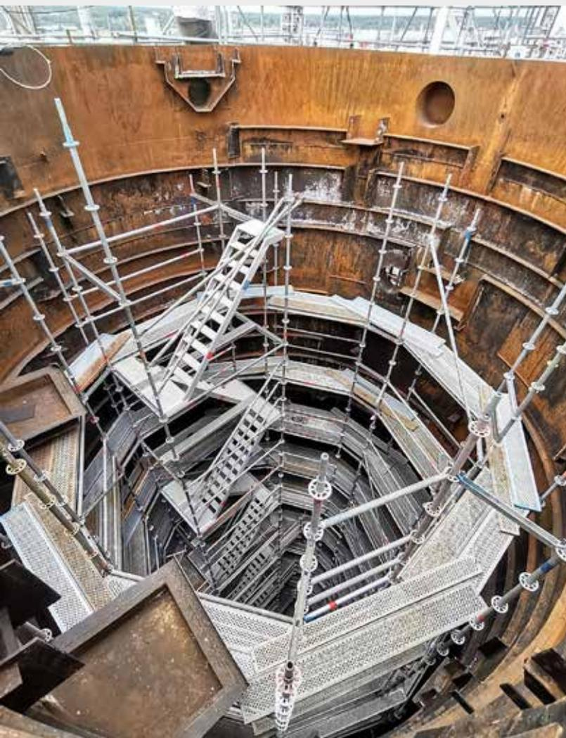
Gerüst in der Hauptkolonne der Rohöl-Destillationsanlage um Zugang für Laserreinigung, Prüffirmen und Reparaturarbeiten zu ermöglichen
